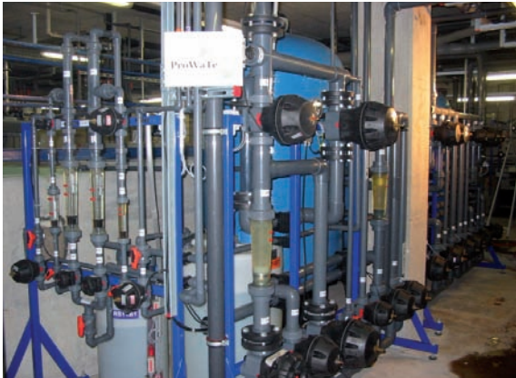
Neue Selektiv-Ionenaustauscheranlage
