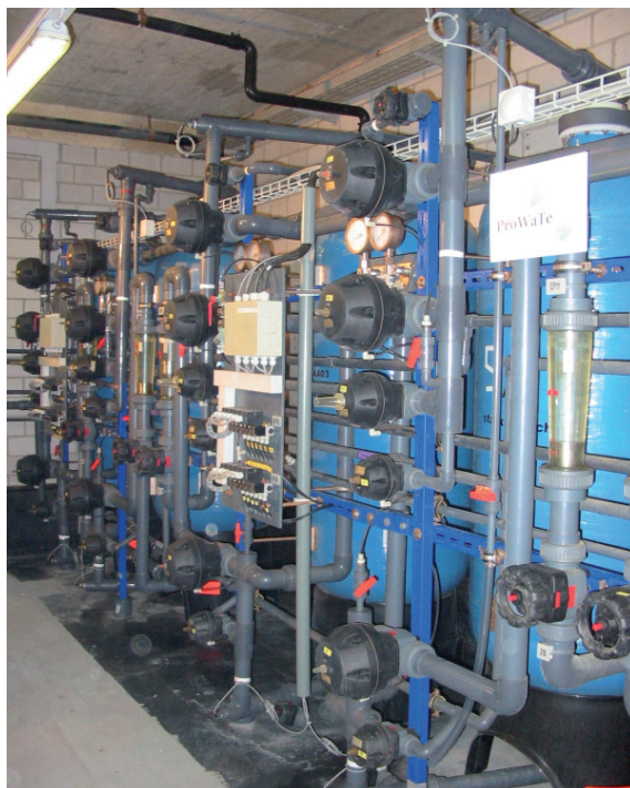
Neue Ionenaustauscher-Kreislaufanlage
